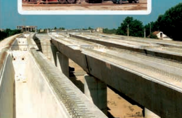
Viadotto Asse Mediano
