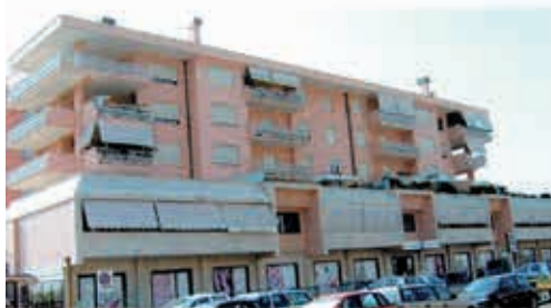
Aversa, realizzazione parco Codelga
