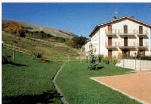
Pescocostanzo, realizzazione complesso "La Morgetta"
