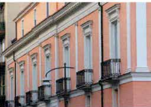
Caserta, recupero e restauro ex Hotel Vittoria
