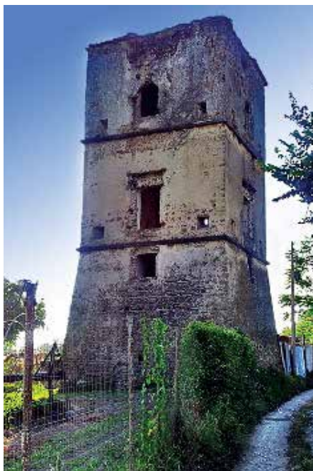
LA TORRE DI CENTORE
