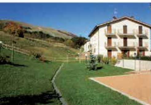
Pescocostanzo, realizzazione complesso "La Morgetta"
