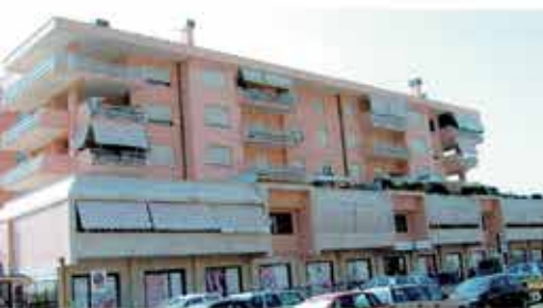
Aversa, realizzazione parco Codelga
