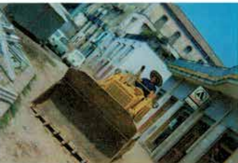
1965: Aversa intervento sul collettore Spierto Ovest
