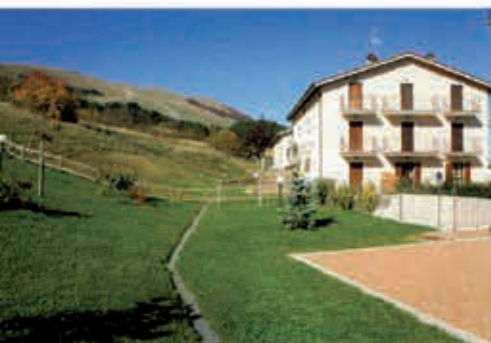
Pescocostanzo, realizzazione complesso "La Morgetta"
