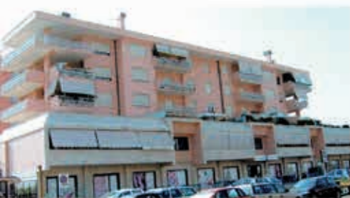
Aversa, realizzazione parco Codelga
