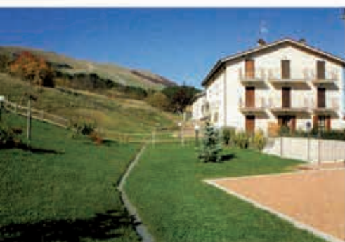
Pescocostanzo, realizzazione complesso "La Morgetta"
